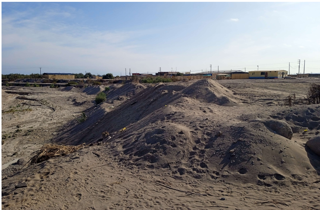
FIGURA N°02: MATERIAL COLMATADO EN EL CAUCE DE LA QUEBRADA HOSPICIO, CON UNA PROFUNDIDAD PROMEDIO DE 1.05 M. ESTO PROVOCA QUE DESBORDAMIENTO DE LA QUEBRADA RÍO SEA MAS INMINENTE.
